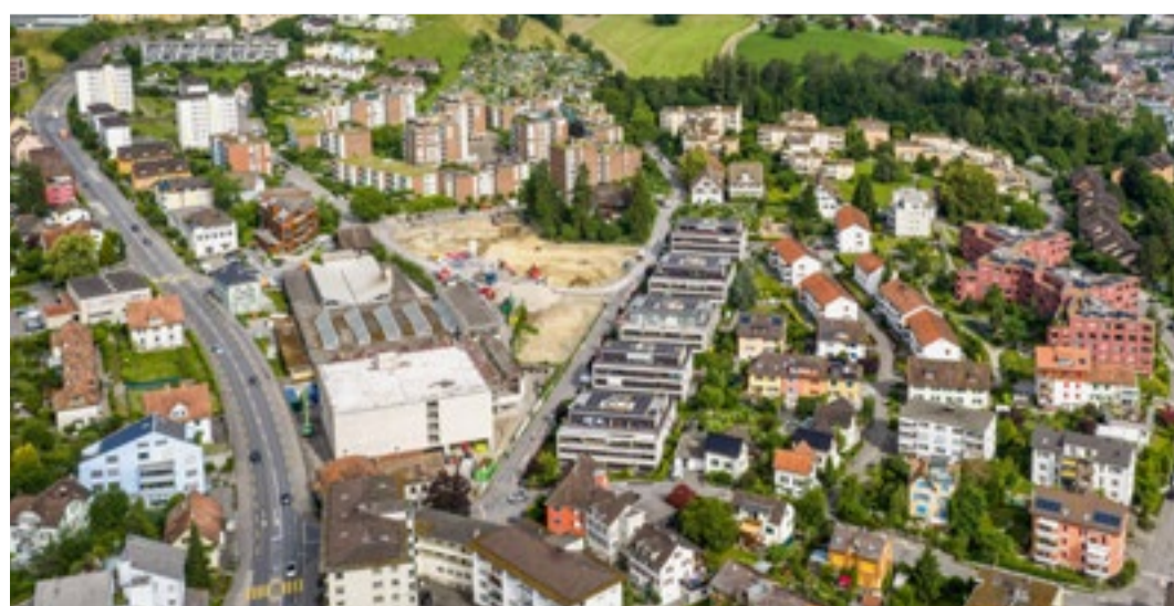
Von oben sieht man, wie gross das MEWA-Areal ist, das nun überbaut wird. Die Fabrikhallen stehen derzeit noch.
